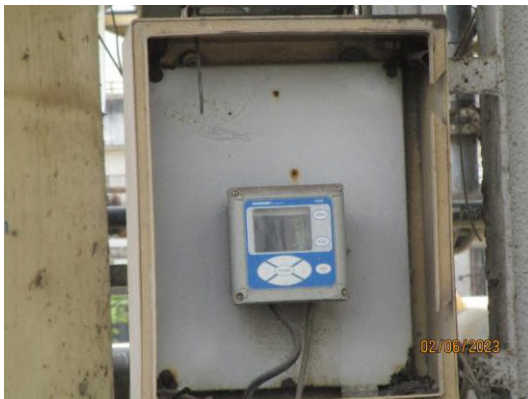
รูปที่ 2-5 เครื่องตรวจวัดคุณภาพน้ำอัตโนมัติ
