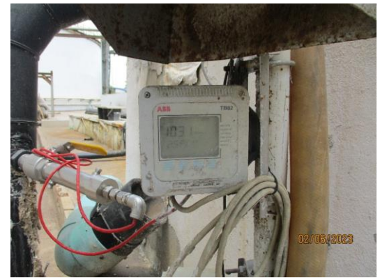
รูปที่ 2-5 เครื่องตรวจวัดคุณภาพน้ำอัตโนมัติ
